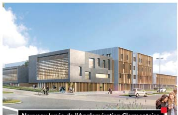
Nouveau Lycée de l'Agglomération Clermontoise Clermont-Ferrand (63) Architecte : CRR Architecture
